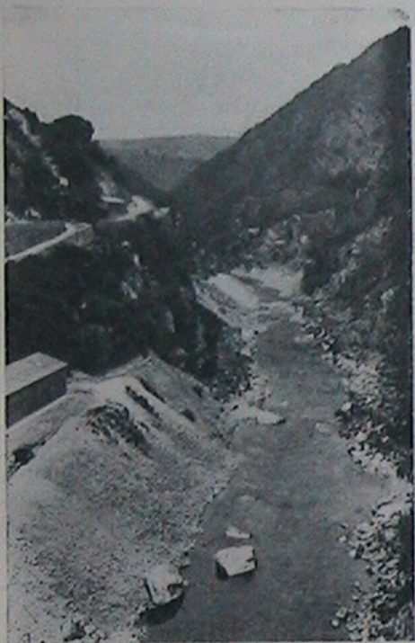
LA CADÈNE. — LES TRAVAUX ET LA ROUTE.
