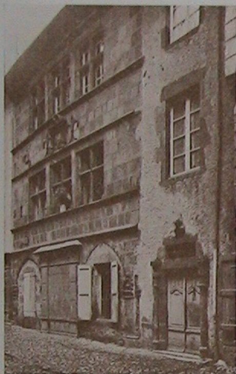
CL. L. Portaller. MUR-DE-BARREZ. l'ancienne maison.
