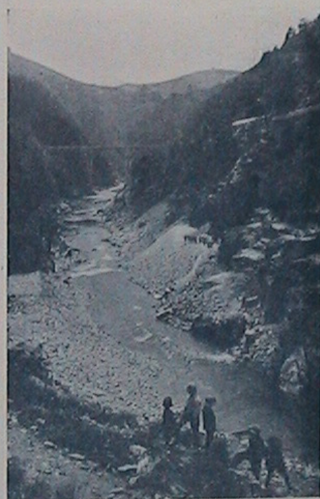
GORGES DE LA TRUYÈRE. Les travaux et le pont.
